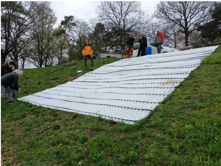
Kiesgitter verbinden und für weiteren Bewässerungsversuch auslegen, um nochmal zu testen, ob der Perlschlauch, bevor er vergraben wird, tatsächlich in der endgültigen Position drucklos funktioniert
