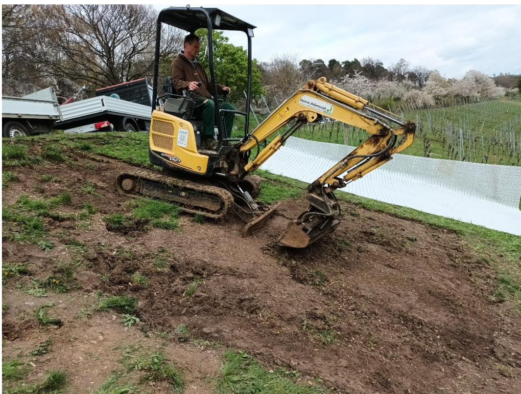
Und natürlich auch an unseren Profi Roland, der sich getraut hat, die 45°-Fläche mit dem Bagger exakt rauszuschälen
