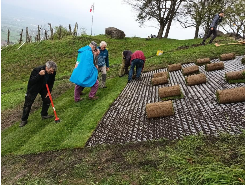
Rollrasen in Kiesgitter einstampfen/reintrampeln
