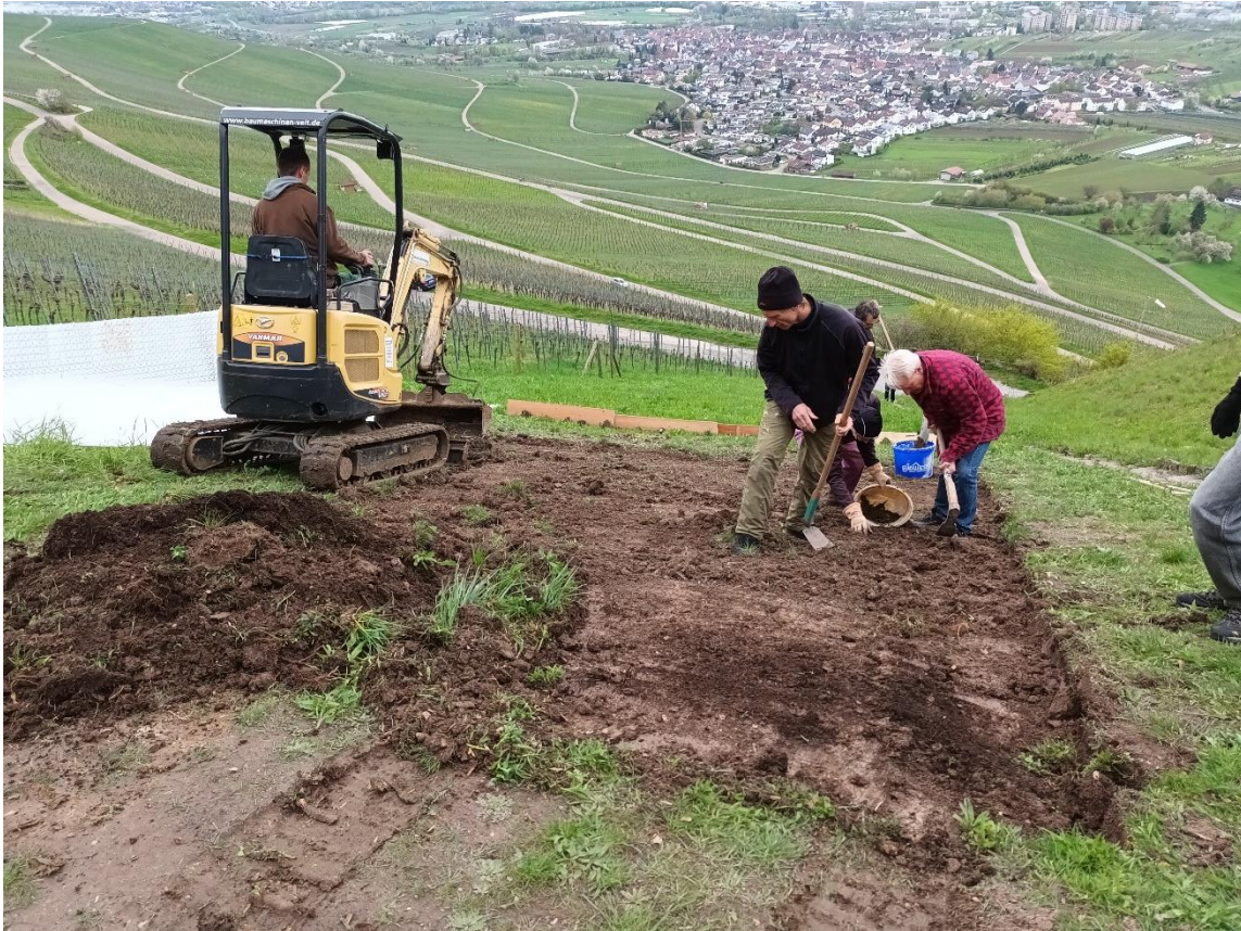
Fläche vollends von Hand eben ziehen und vorverdichten
