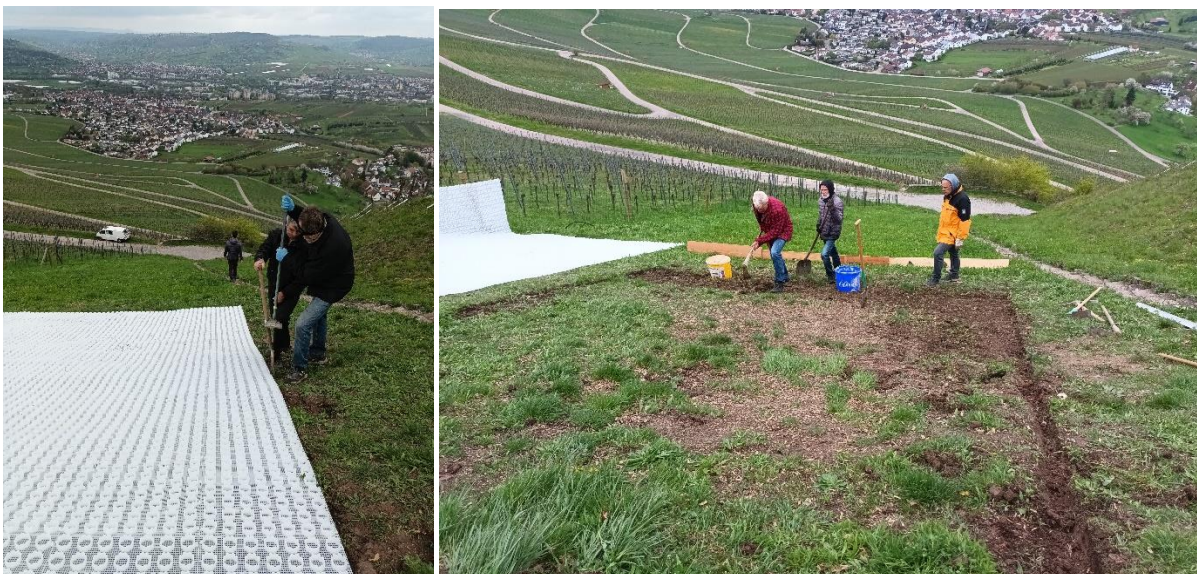
Auszugrabende Fläche für Bagger markieren und rings rum ein Spaten breit von Hand ausgraben.
