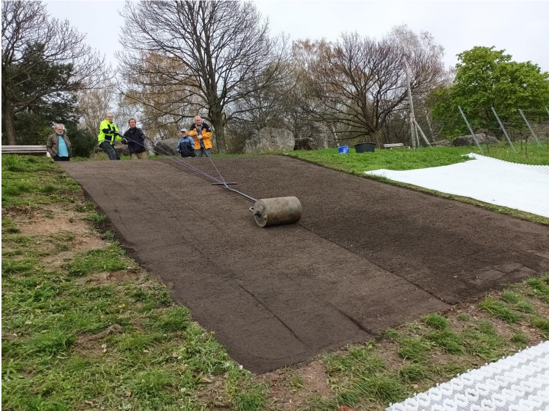
Rasenerde verdichten mit „ferngesteuerter“ Walze, ohne Fläche und Perlschlauch zu betreten
