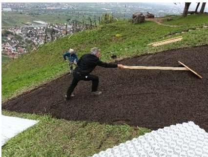
Rasenerde eben ziehen mit Holzschieber und Kiesgitter (Remstaler Nivilierpatent)
