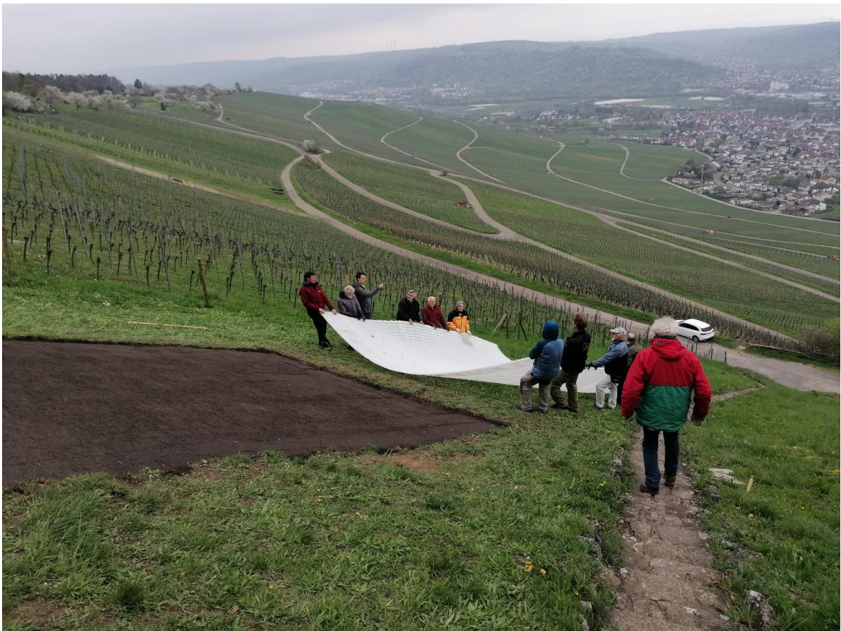
Kiesgitterverbund mit vereinten Kräften frei schwebend auf Fläche positionieren
