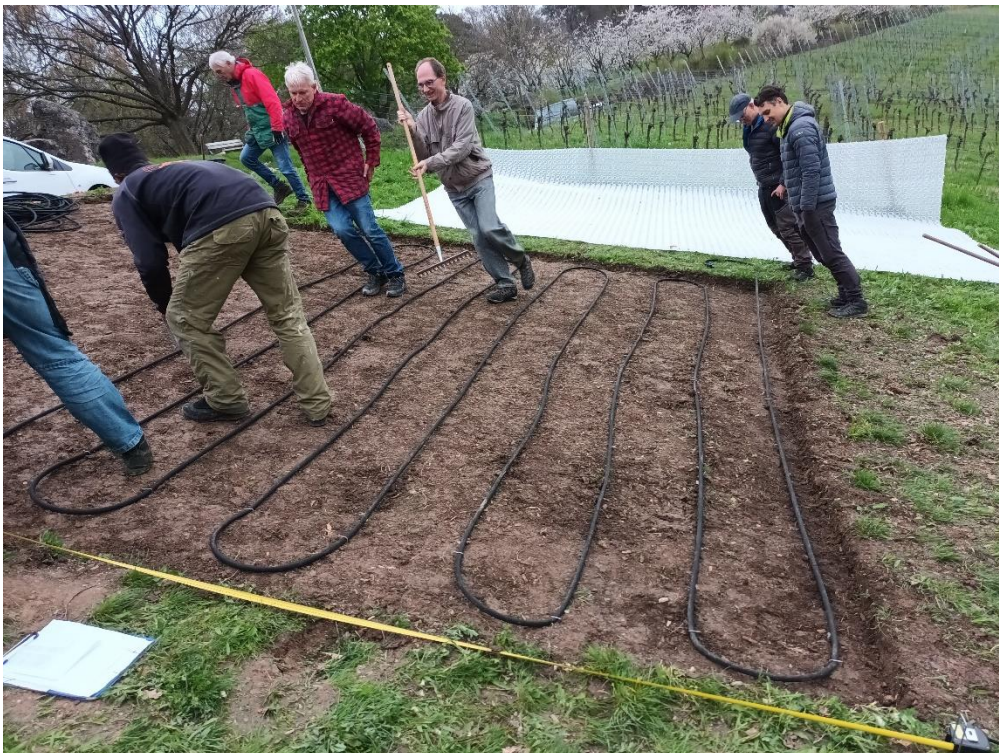
Perlschlauch genau nach berechneten Vorgaben verlegen und mit Erdnägeln befestigen. In unserem Fall 18 Querstränge im Abstand von 39,6 cm. Perlschlauch seitlich markieren, um ihn später nicht mit den Erdnägeln beim Kiesgitter befestigen zu treffen.
